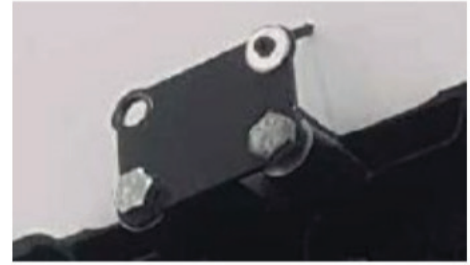
Ekranları, çevreleyen unsurlara sabitlemek için kullanılmış yetersiz yöntemlere örnekler
