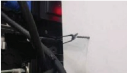
Ekranları, çevreleyen unsurlara sabitlemek için kullanılmış yetersiz yöntemlere örnekler
